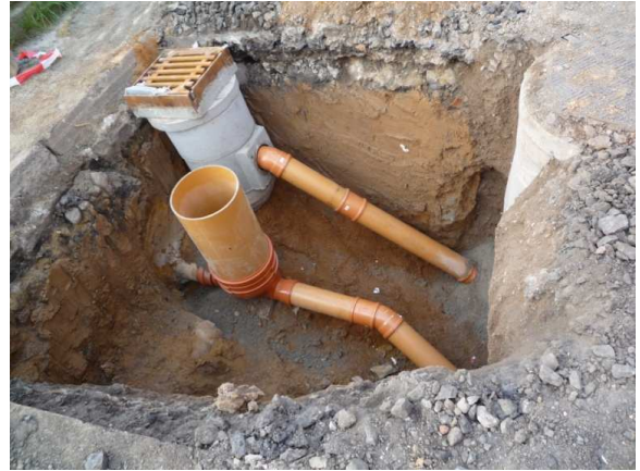
Připojení u domu 1149
