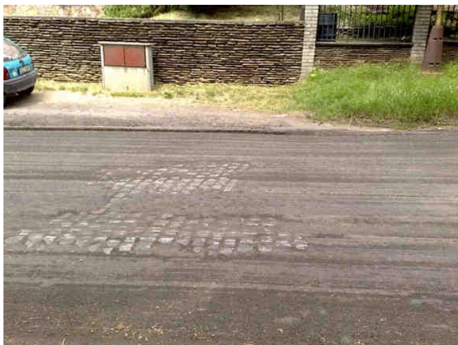
Po odfrézování asfaltu
