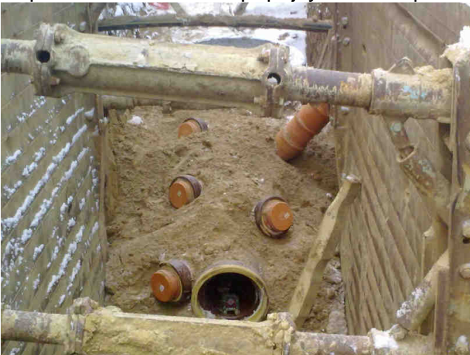
Příprava na kanalizační přípojky a uliční vpusti
