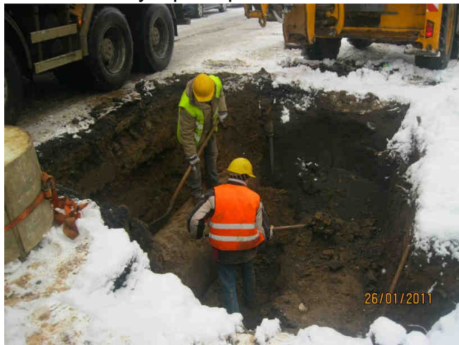
Výkopové práce detail
