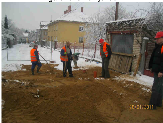
Budoucí Revizní šachta a uliční vpust' proti garážovému vjezdu
