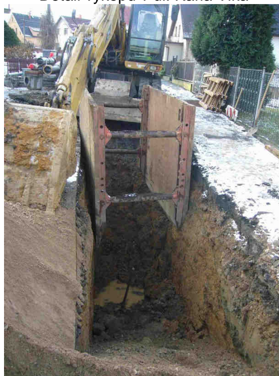
Detail výkopu v ul. Karla Vika
