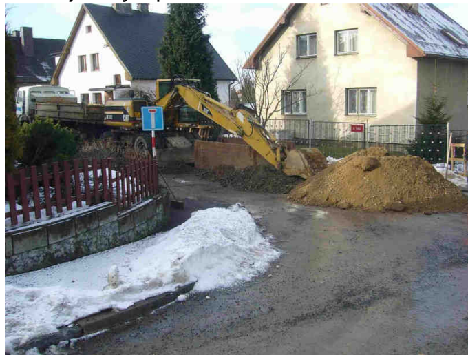
Zahájení výkopu v Karla Vika u Lidické ulice
