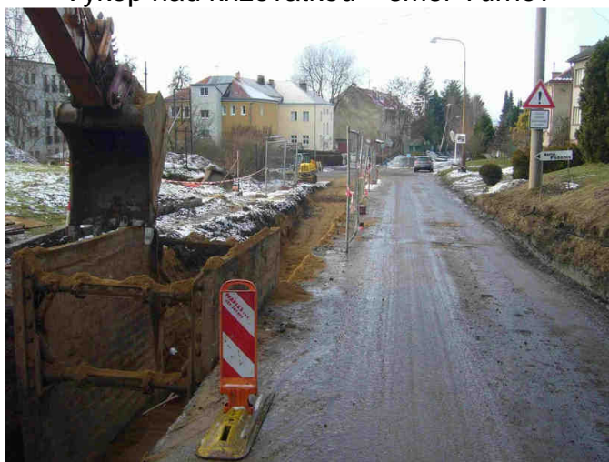
Výkop nad křižovatkou – směr Turnov
