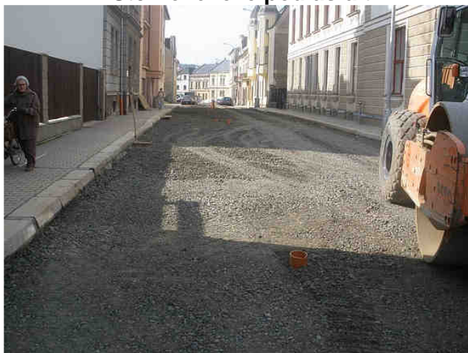
Štěrkové lože pod asfalt
