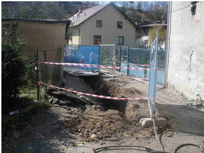
Směr sídliště – stav nad komorou před asfaltováním
