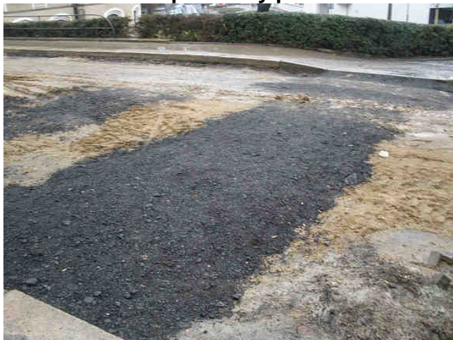
Štěrkové lože pod asfalt
