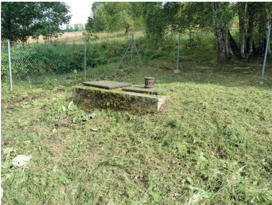
Pohled na vodojem
