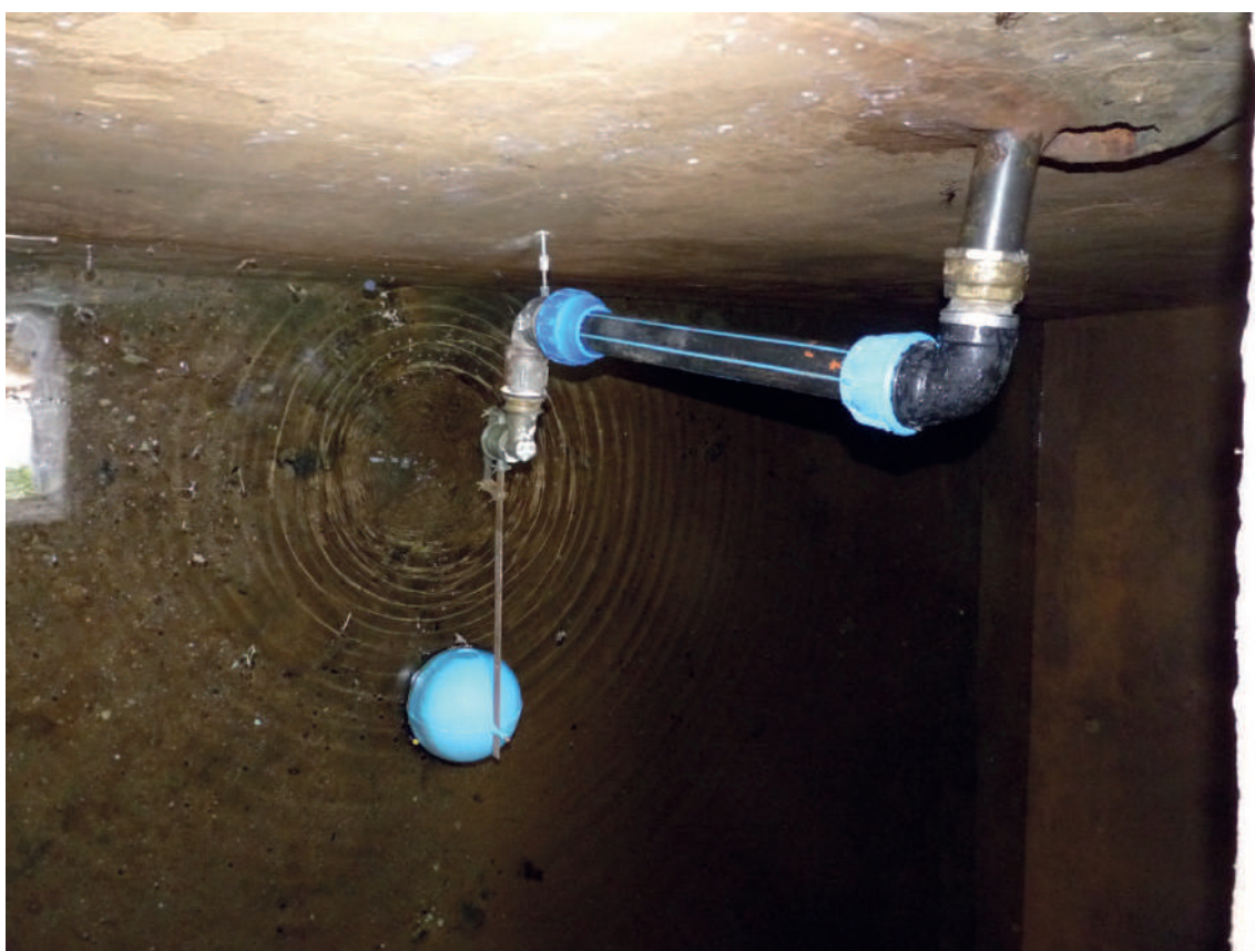
System dopouštění akumulční komory
