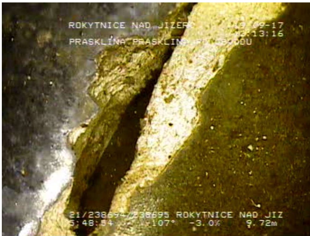
Obr. č. 21: 3 - Horní Rokytnice (238695 - 238694) - Tvorba prasklin, posunutý spoj. - Rokytnice nad Jizerou
