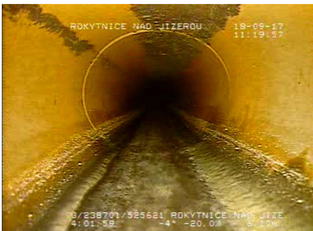
Obr. č. 4: 4 - Horní Rokytnice (238702 - 1034759) - Deformace stoky - ovalita, deformace dna. - Rokytnice nad Jizerou
