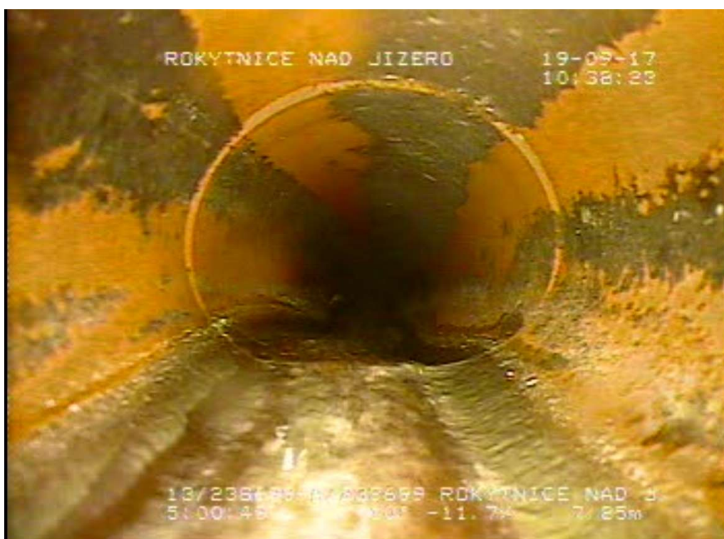
Obr. č. 10: 2 - Horní Rokytnice (238699 - 1034761) - Deformace stoky – ovalita. - Rokytnice nad Jizerou
