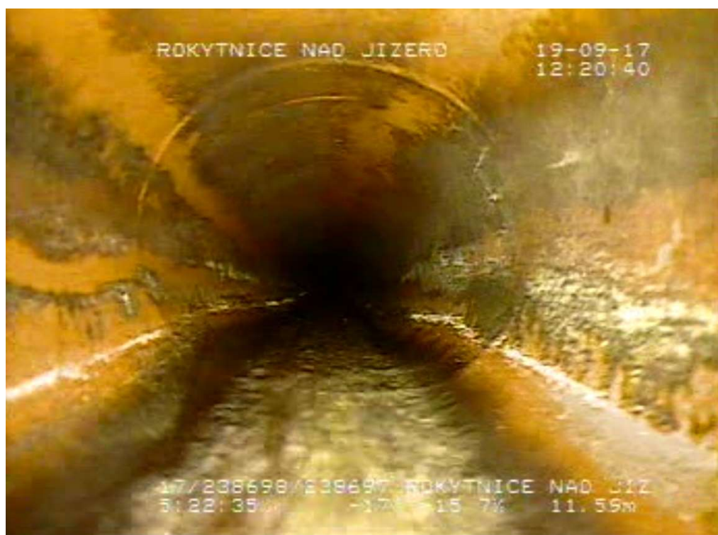
Obr. č. 16: 2 - Horní Rokytnice (238697 - 238698) - Deformace stoky – ovalita. - Rokytnice nad Jizerou
