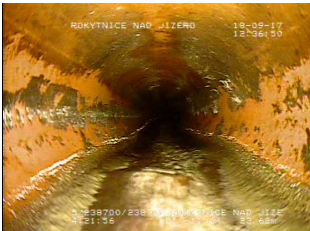
Obr. č. 6: 3 - Horní Rokytnice (238701 - 1034760) - Nerovnost dna. - Rokytnice nad Jizerou
