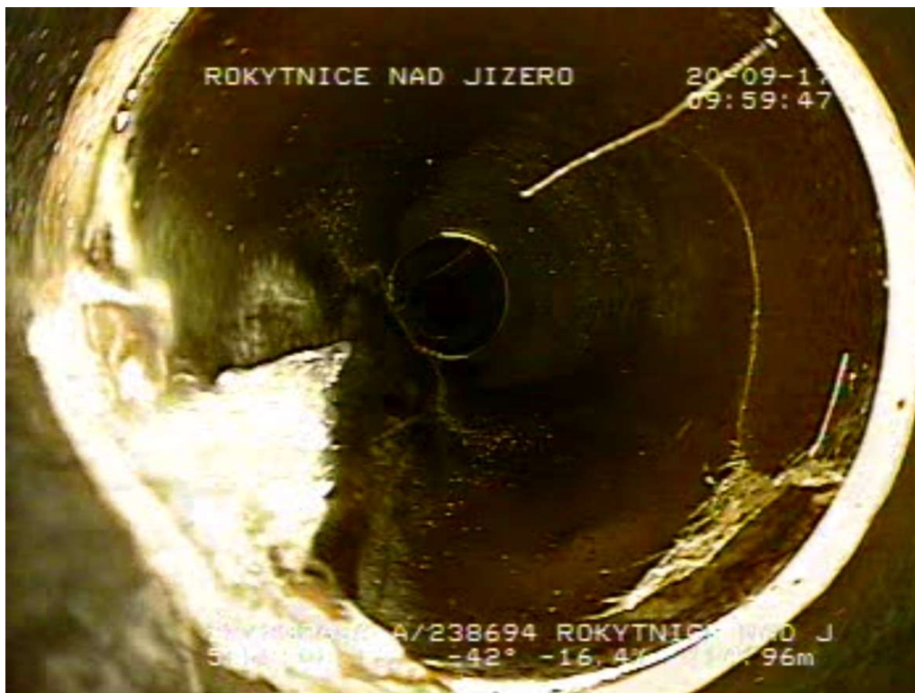
Obr. č. 23: 3 - Horní Rokytnice (238694 - 1054869) - Tvorba prasklin. Kořeny. - Rokytnice nad Jizerou
