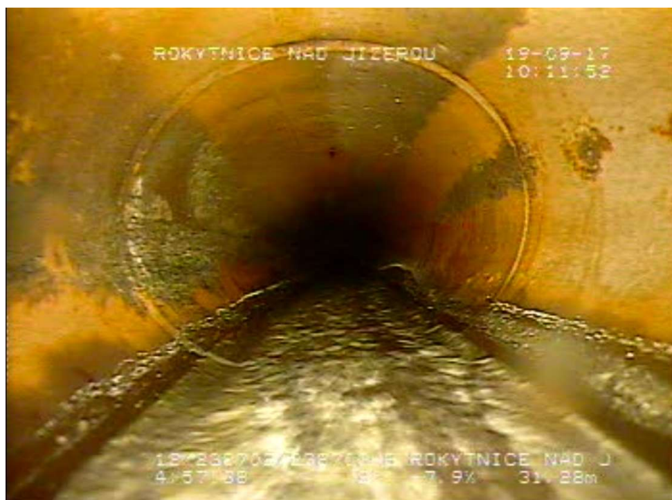
Obr. č. 2: 3 - Horní Rokytnice (1034757 - 238702) - Deformace stoky – ovalita. - Rokytnice nad Jizerou
