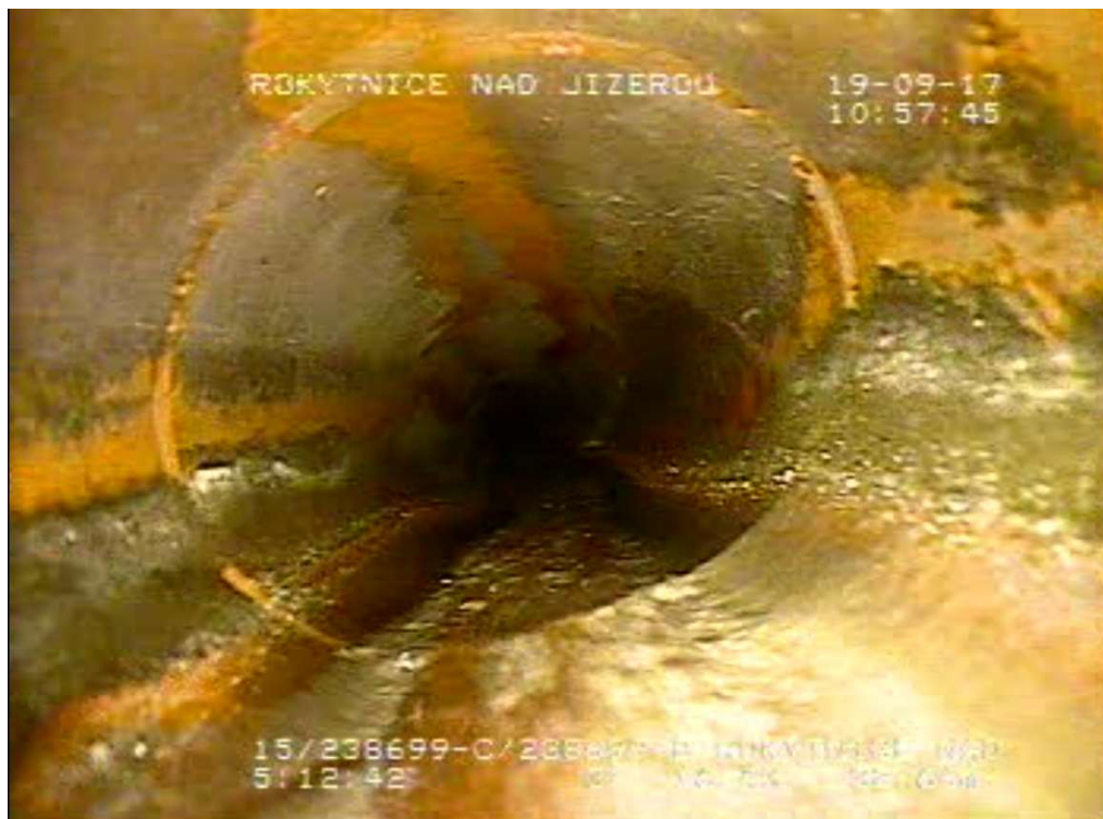
Obr. č. 13: 2 - Horní Rokytnice (1034762 - 1034763) - Deformace stoky – ovalita nerovnost dna. - Rokytnice nad Jizerou
