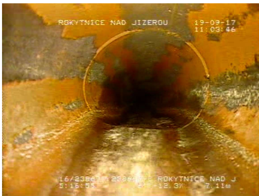
Obr. č. 14: 2 - Horní Rokytnice (1034763 - 238697) - Deformace stoky – ovalita. - Rokytnice nad Jizerou
