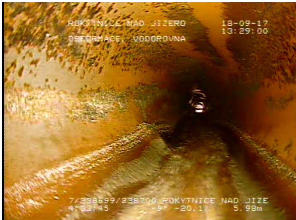
Obr. č. 9: 3 - Horní Rokytnice (238700 - 238699) - Deformace stoky - ovalita, deformace dna. - Rokytnice nad Jizerou
