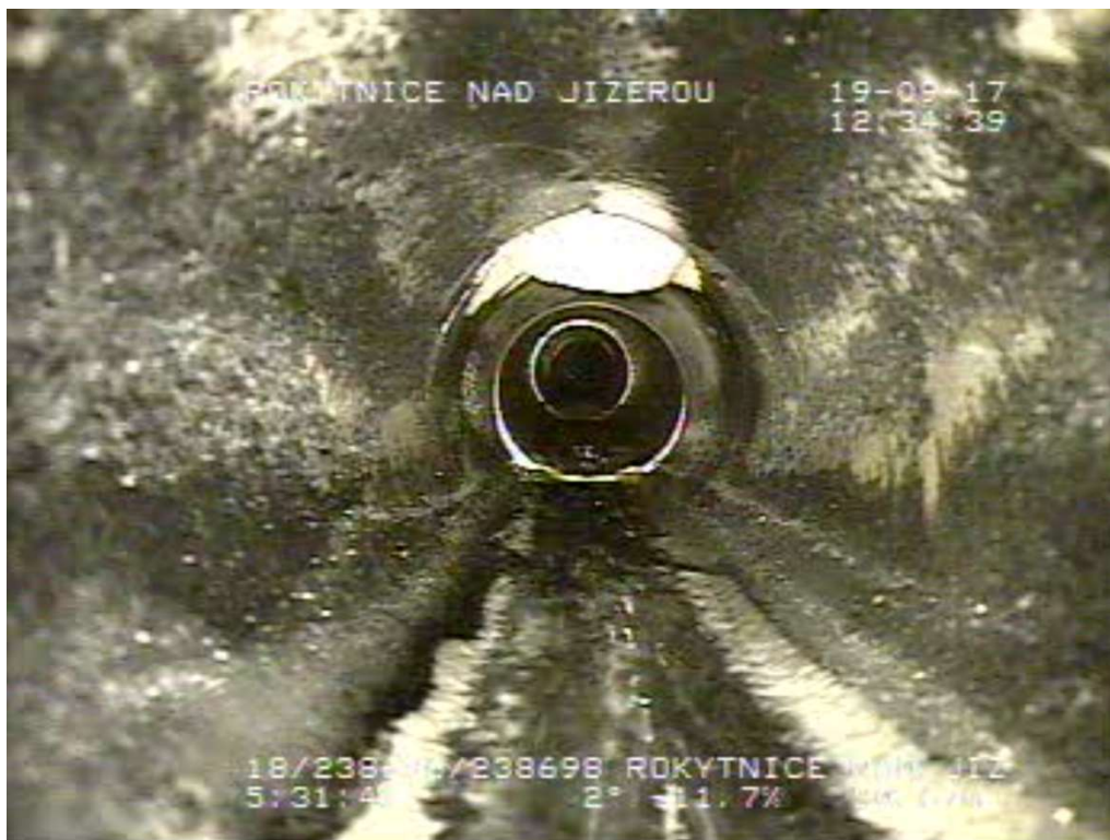
Obr. č. 17: 3 - Horní Rokytnice (238698 - 238696) - Napojení kanalizační přípojky PVC 150 shora. - Rokytnice nad Jizerou
