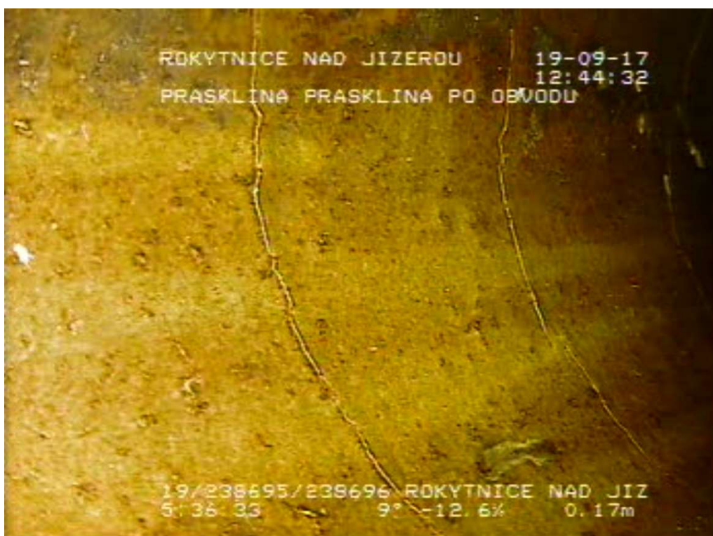
Obr. č. 18: 3 - Horní Rokytnice (238696 - 1034764) - Tvorba prasklin. - Rokytnice nad Jizerou
