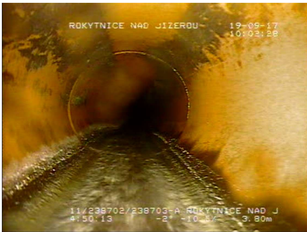
Obr. č. 1: 3 - Horní Rokytnice (1034758 - 1034757) - Deformace stoky – ovalita. - Rokytnice nad Jizerou
