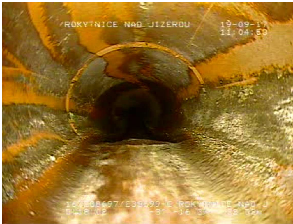
Obr. č. 15: 2 - Horní Rokytnice (1034763 - 238697) - Deformace stoky – ovalita. - Rokytnice nad Jizerou
