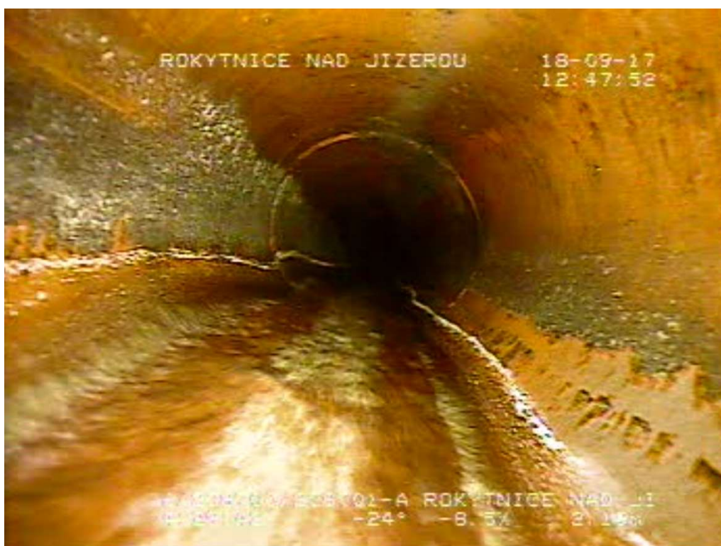
Obr. č. 8: 3 - Horní Rokytnice (1034760 - 238700) - Deformace stoky - ovalita, deformace dna. - Rokytnice nad Jizerou
