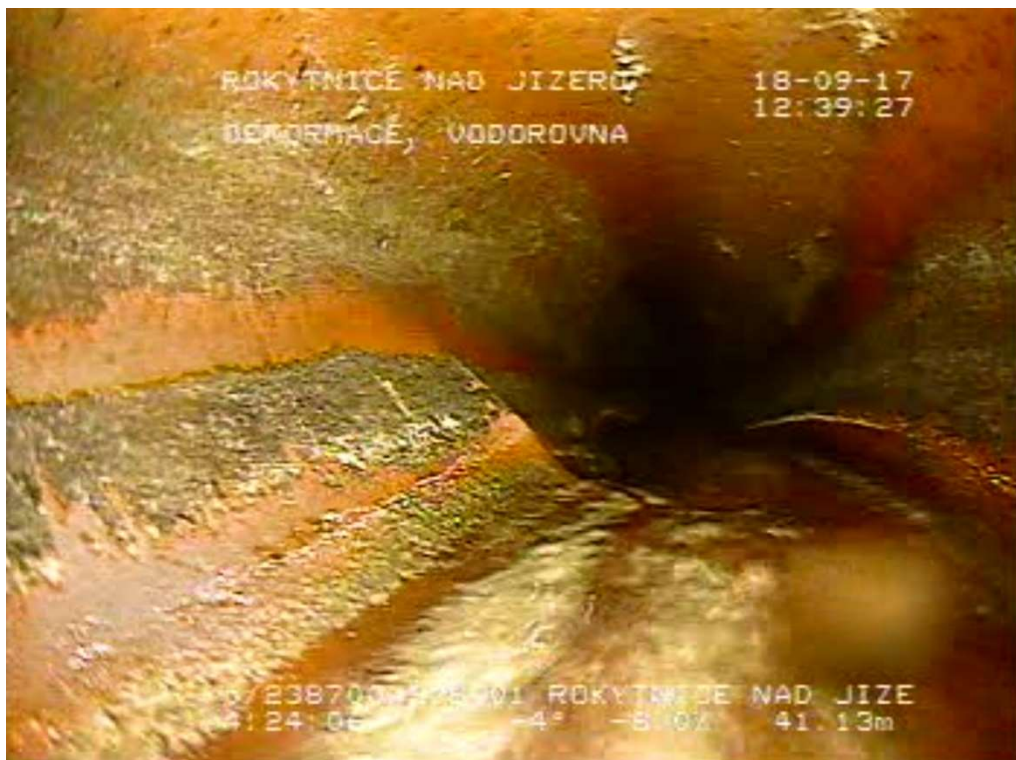
Obr. č. 7: 3 - Horní Rokytnice (238701 - 1034760) - Nerovnost dna. - Rokytnice nad Jizerou
