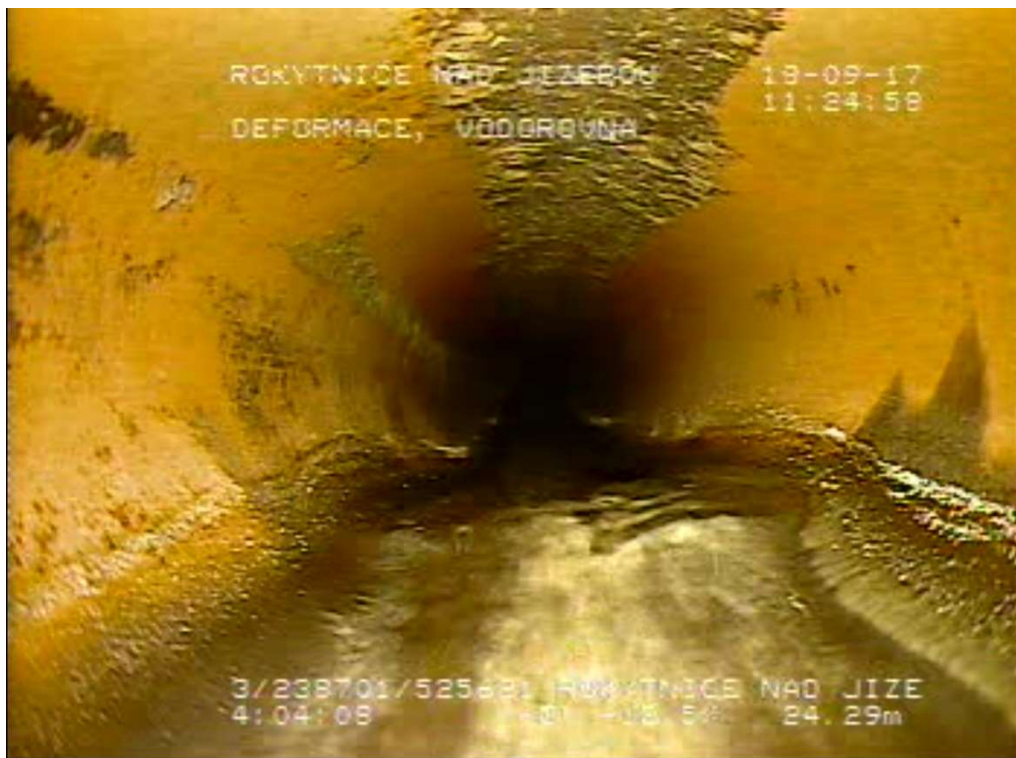
Obr. č. 5: 3 - Horní Rokytnice (238702 - 1034759) - Nerovnost dna, výškový zlom. - Rokytnice nad Jizerou
